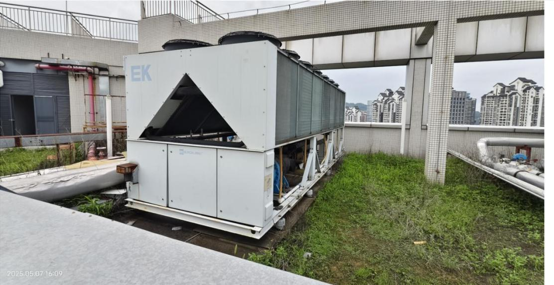
天面新空调主机安装于旧空调主机区域，由水管与消防管分割成三个区域，尺寸分别为7米\*8.6米、7米\*8.6米、6.3米\*8.6米，要求18台新空调主机全部安装于该区域范围，主机间距必须满足国家相关规范与维修要求。
