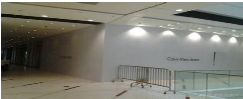
图二：围蔽材料—木夹板、各类彩钢板
